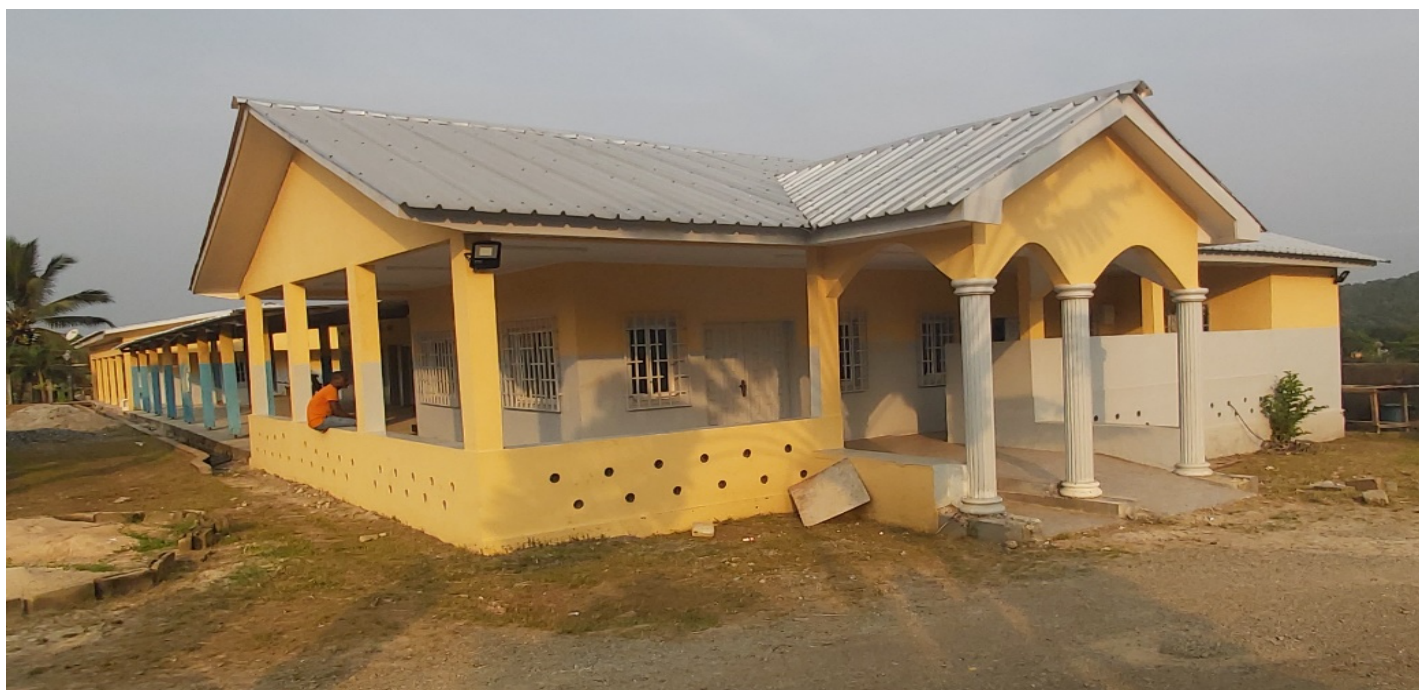
Centre médical de Ndjolé après les travaux de réhabilitation opérés (décembre 2022).
